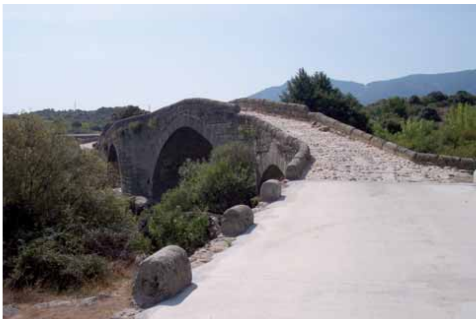
Puente medieval de la Yedra sobre el río Alberche en Cebreros
