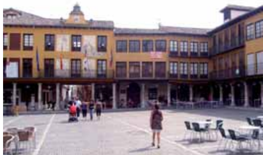
Plaza Mayor de Tordesillas.
