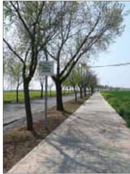
Nuevo acerado y alumbrado en el camino del cementerio
