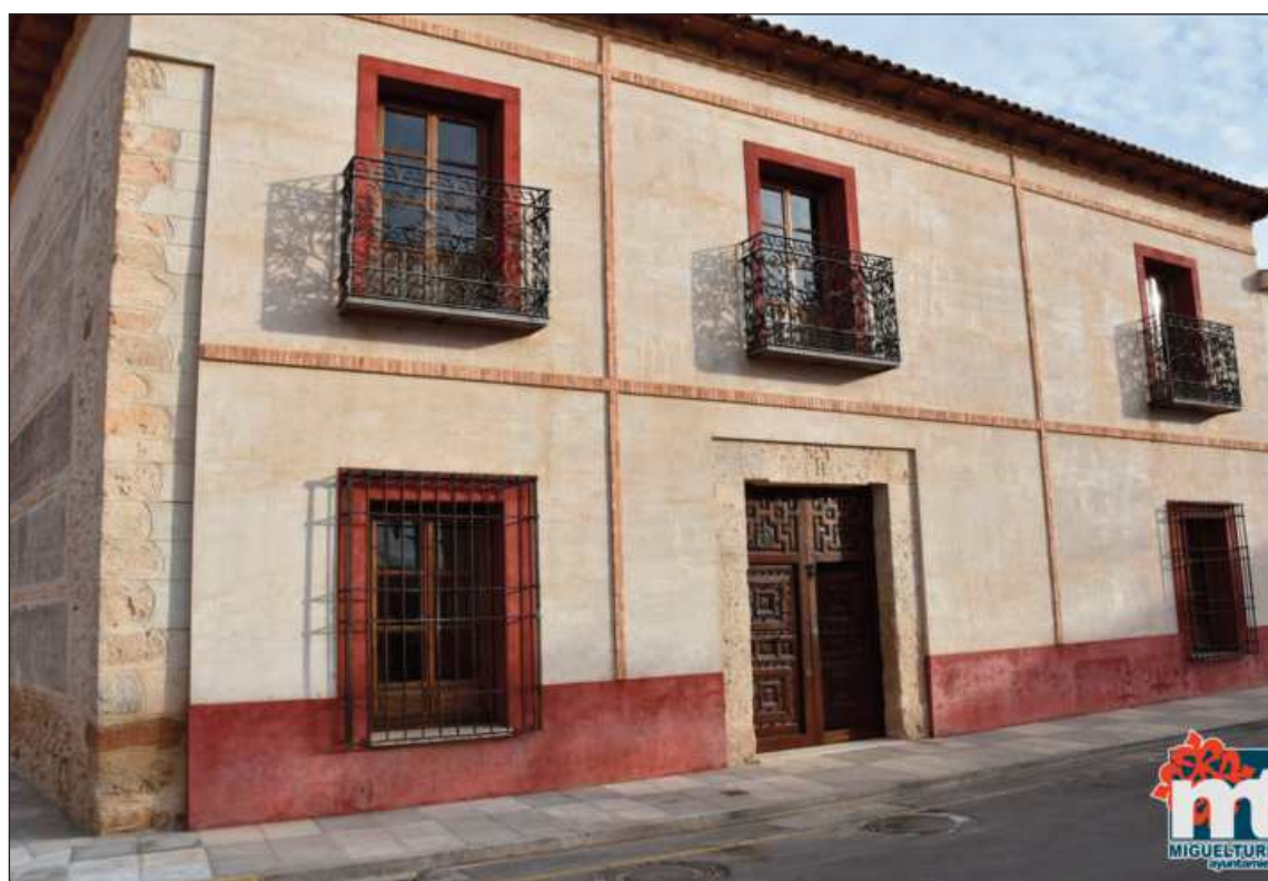
La “Casa de la Capellanía” o “Casa de los Abenza” alberga las instalaciones multifuncionales de la Biblioteca
