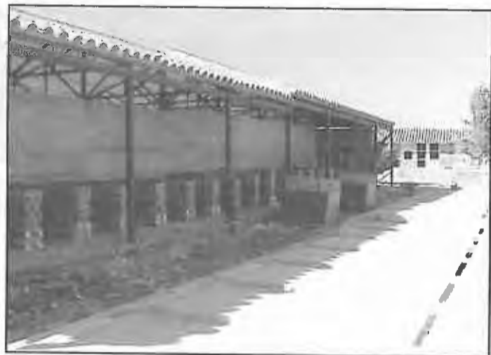
Construcción de nuevos nichos
