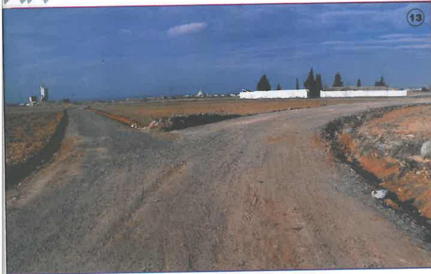
Foto 13: Arreglo de Caminos
